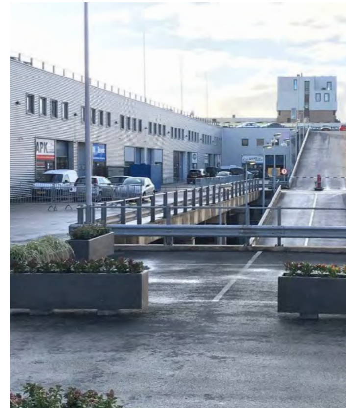
Binck twins, gestapeld bedrijfsgebouw, Den Haag
