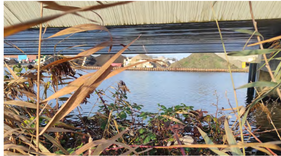
Zicht onder de Sontbrug in richting Deense Haven / zandoverslag
