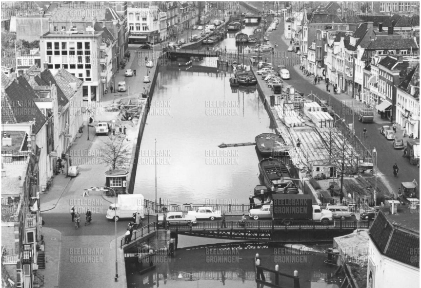
situatie 1960: Steentilbrug, werkzaamheden ter hoogte nieuwe Kattenbrug
