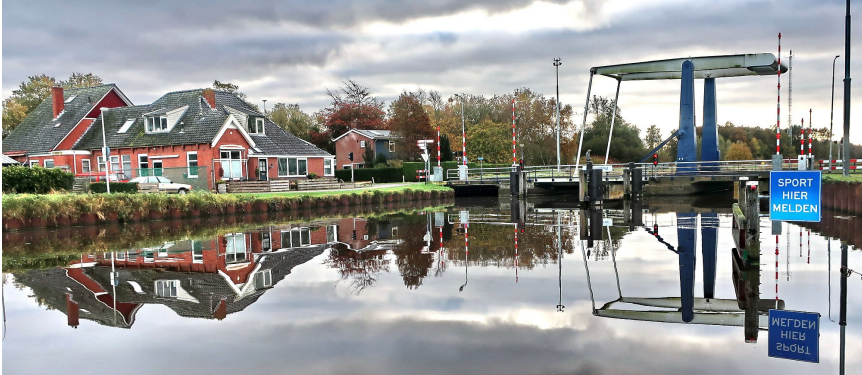
Meerwegbrug over het Noord Willemskanaal
