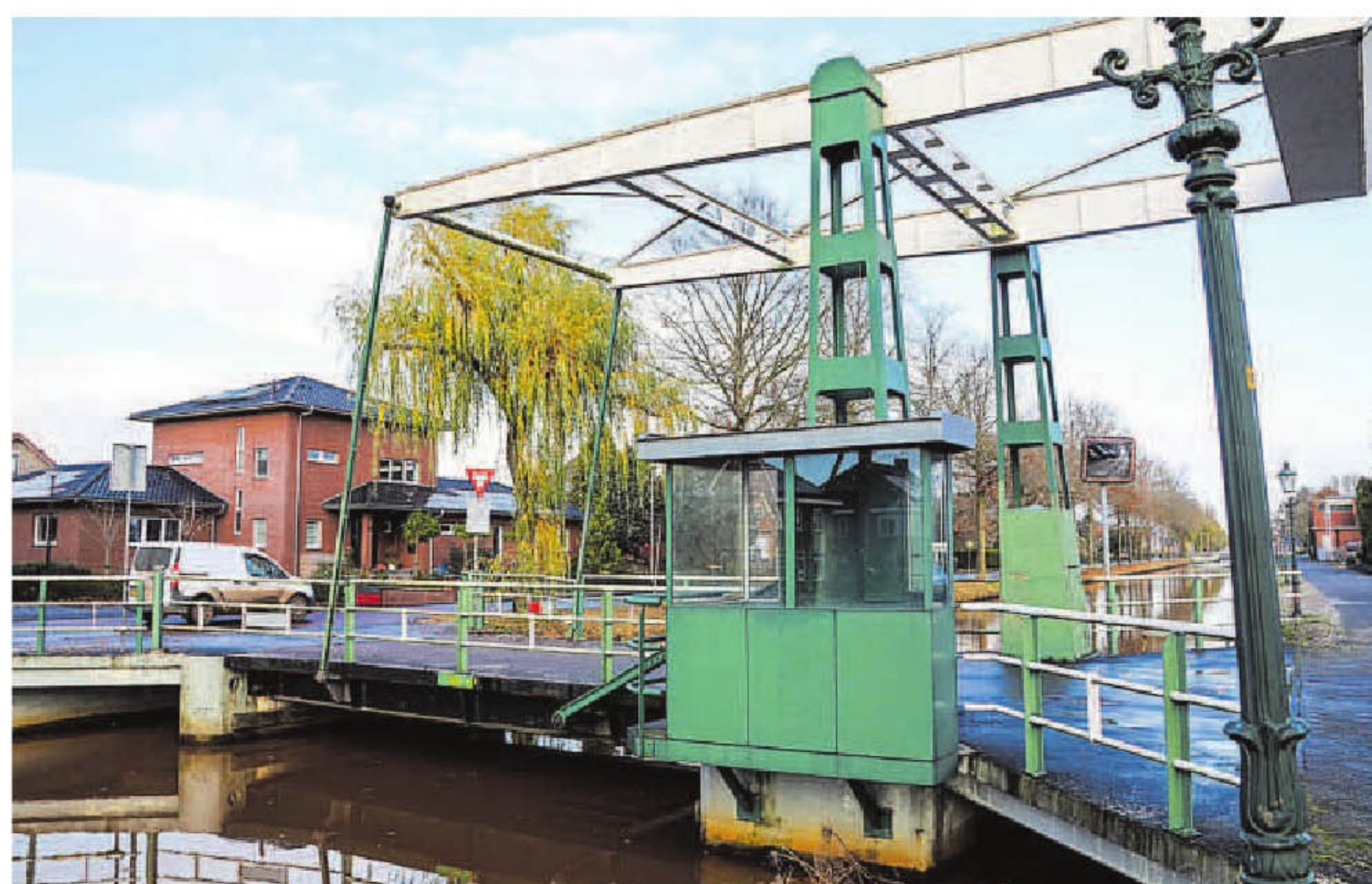
De Unionbrug is het enige rijksmonument onder de bruggen in Pekela.
