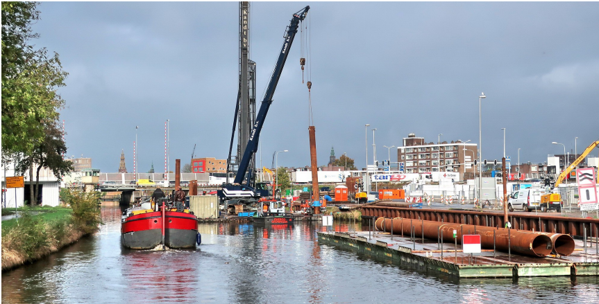
Werkzaamheden Noord Willemskanaal, Julianabrug, november 2021
